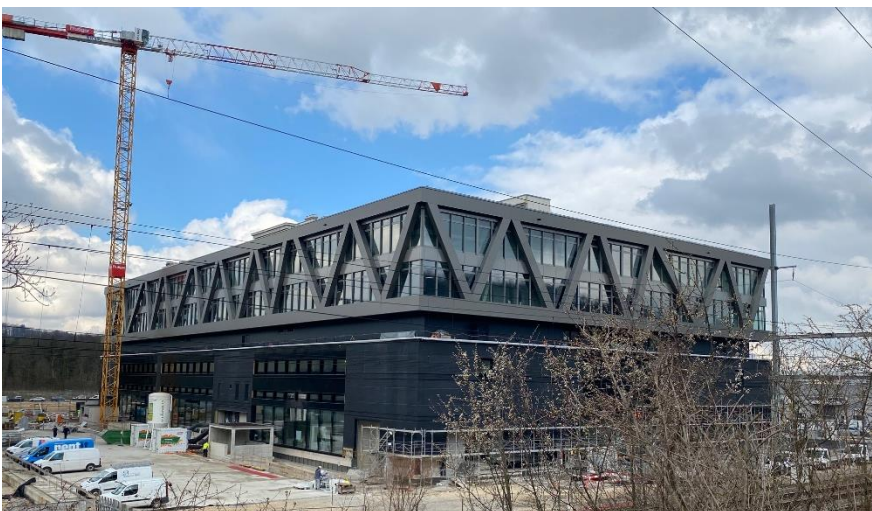
Avancement des travaux à l'uptownBasel (Source image : uptownBasel)
